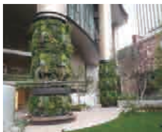
▶ 壁面緑化施工例：丸の内パークビルディング
