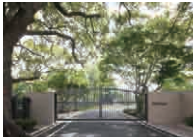
▶支柱と扉が一体となって回転、蝶番や吊り金具のない支柱回転式開戸
