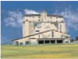
▶乾燥調製貯蔵施設 「カントリーエレベータ」
