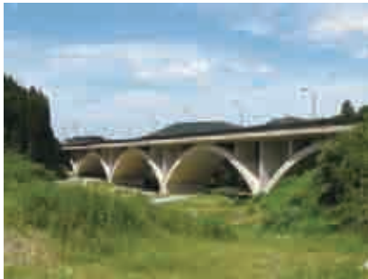
▶宮の杜大橋（石川県加賀市山中町） 鉄筋コンクリート構造の5径間連続アーチ橋で、技術面で工夫を凝らした設計を行っています。
