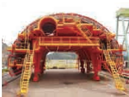
▶ 新東名高速道路 大断面トンネル覆工工事用型枠
