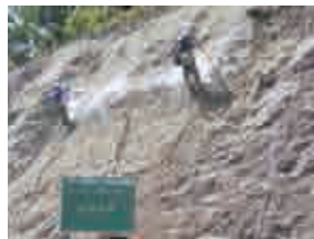
▶セーフマン吹付工法（フライアッシュブレックスセメントによる低リバウンド吹付工法）
