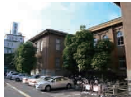
▶ 山梨県議会議事堂（FST工法・施工例）
