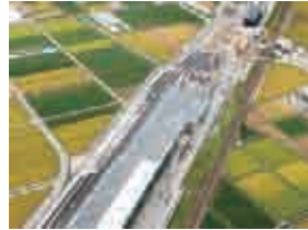
▶ 「CKeめっき」(北陸新幹線白山車両基地) 溶融亜鉛めっきとして世界で初めて鉛レス、カドミレスを実現。公共の建造物にも幅広く使用されています。
