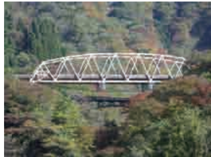
▶濁澄橋（石川県白山市） 鋼トラス橋の耐荷力アップを目的に補強した橋梁です。
