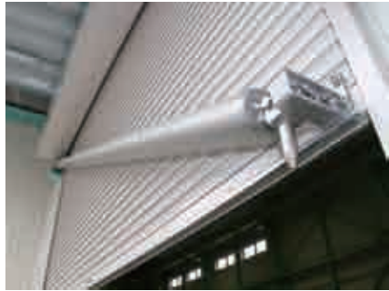
▶ 大型シャッターガード実装例
