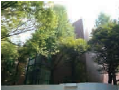
▶ 東京都美術館（FST工法・施工例）
